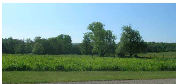
La station d'épuration d'Allenwiller
